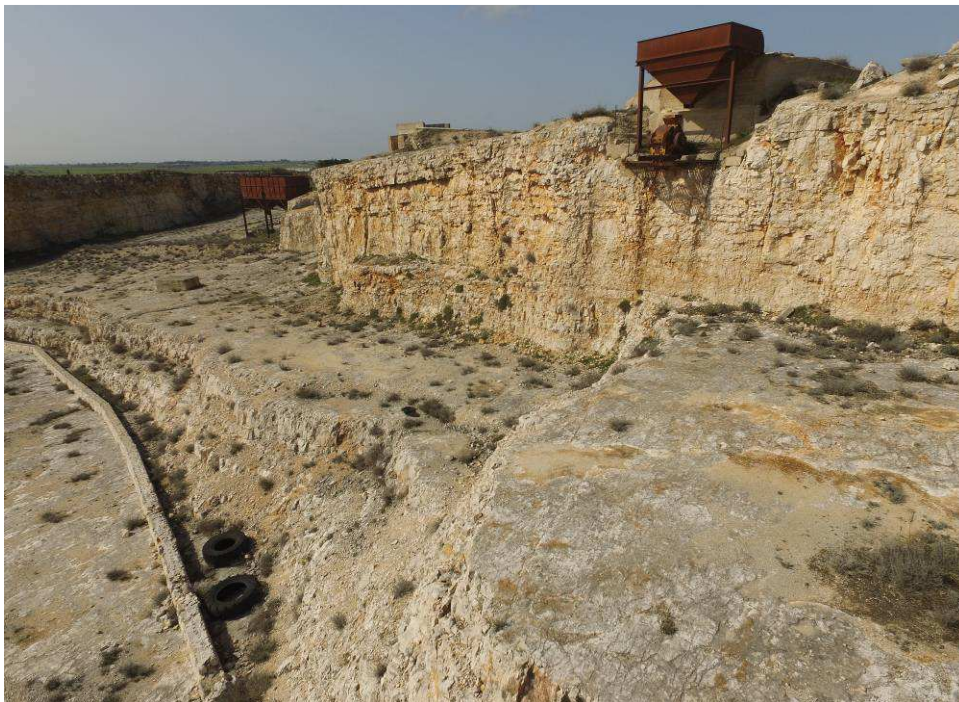
Fig.10 - Gradone del fronte basso di appoggio della passerella e parete NW arretrata (vista da drone verso Sud)
