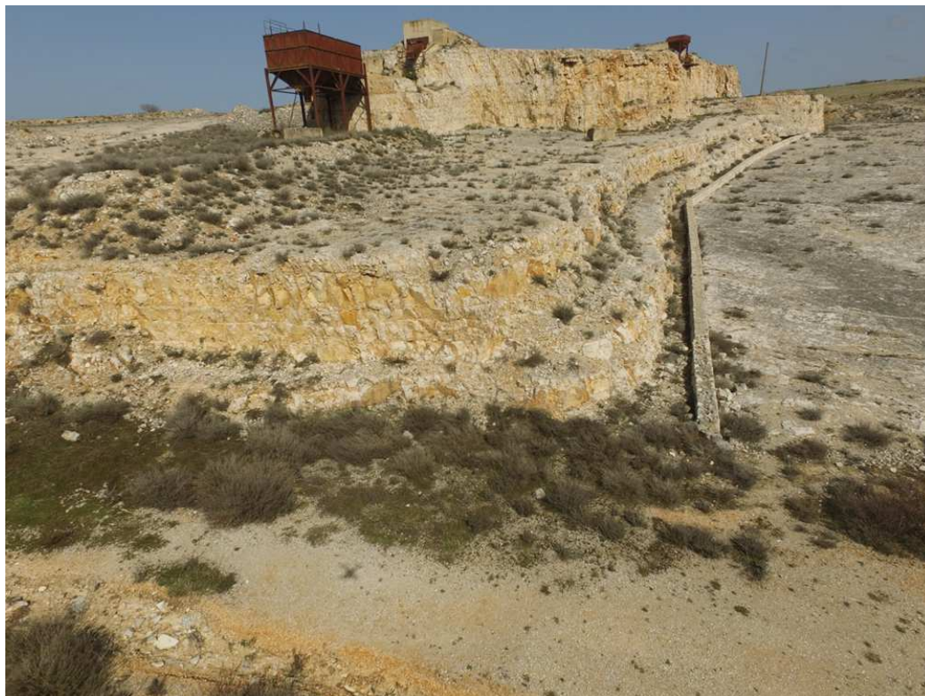
Fig.4 - Uno dei terrazzamenti della cava sul fronte NW (Archivio SABAP, foto da drone, marzo 2017).
