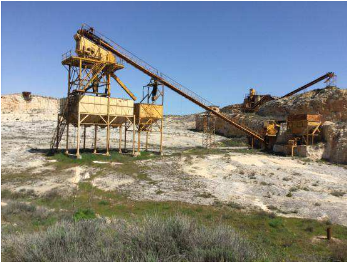
Fig. 18: Dettaglio dei macchinari abbandonati, testimonianza della pregressa attività estrattiva operata all'interno della ex cava in località Pontrelli
