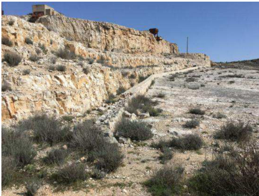
Fig. 6: Muro di contenimento realizzato dalla Soprintendenza Archeologica nel 2004
