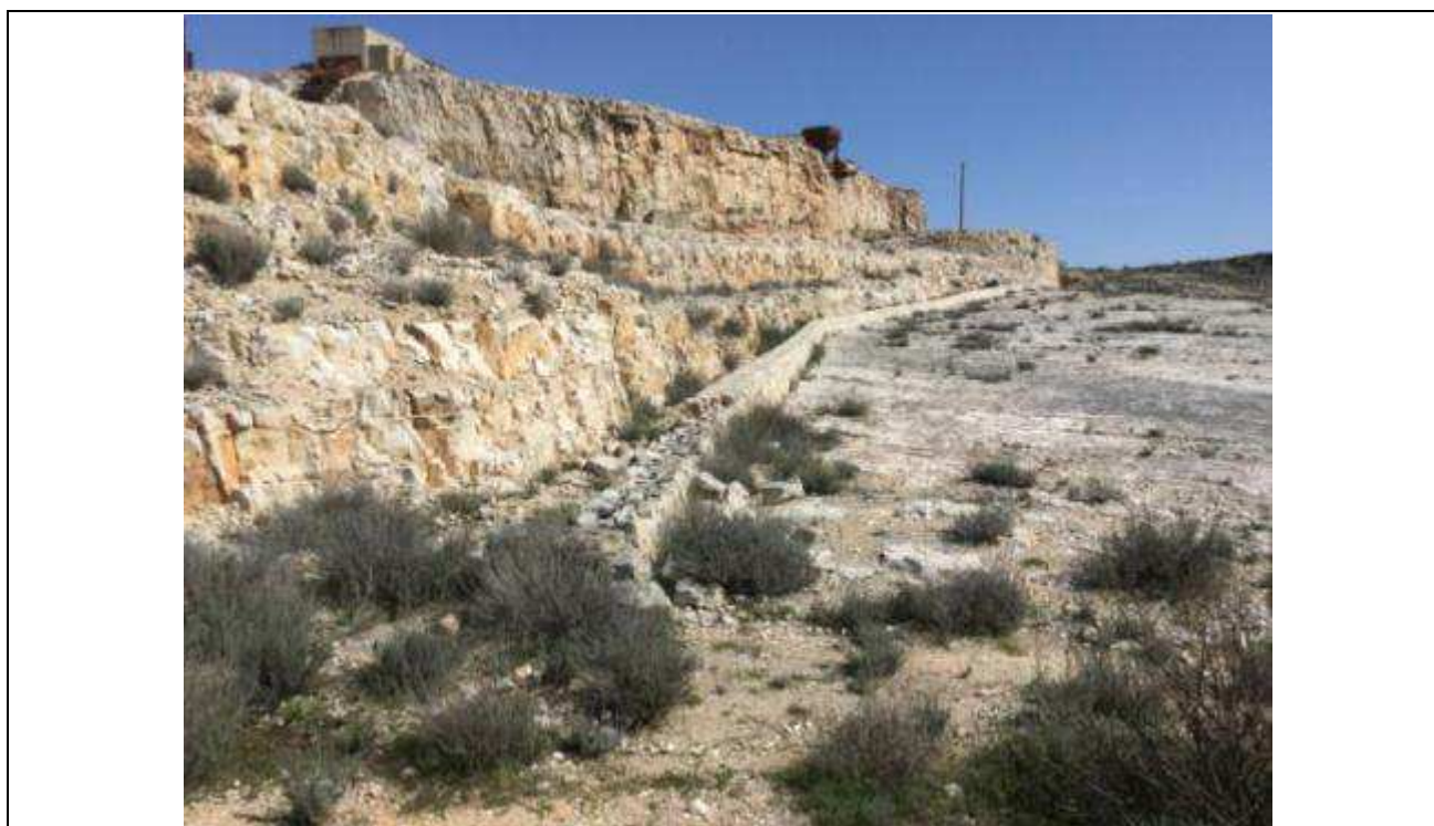
Muro di contenimento realizzato dalla Soprintendenza Archeologica nel 2004
