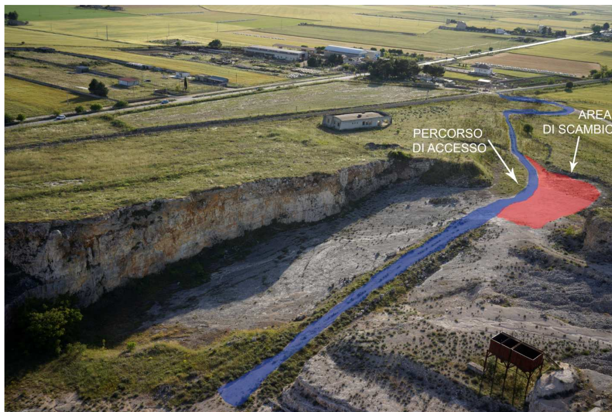
Fig. 20: Individuazione dell'area di scambio e del percorso di accesso durante i lavori all'interno della ex cava in località Pontrelli, denominata "valle dei dinosauri"
